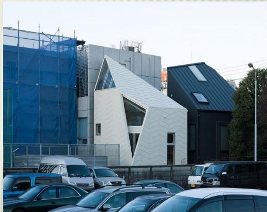
内部的主材是落叶松胶合板，外表皮采用了镀锌钢板，内外材质的分别统一使得空间体验更加纯粹。每个面板切成平行四边形放在人字形图案。这种模式探讨了镀锌钢板的象牙立面及贯彻应用于外部以及内部重复，唤起更多的三维的经验。
