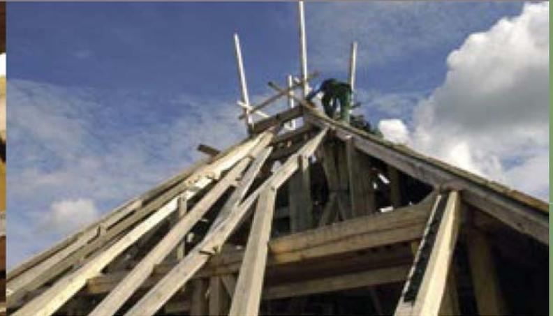
Vesikahta ja solinäkä kantavaa avaruusristikon keskainen liitos. I-litokassa ei
