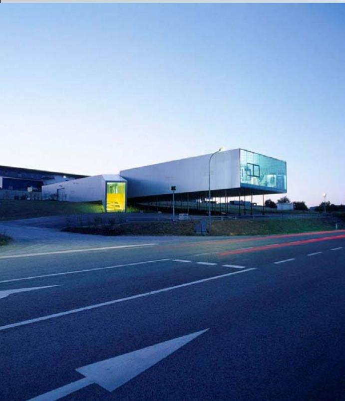
◀ 整座建筑采用了悬浮式的结构，直线的形式向各个方向延伸开来，建筑的下方则是停车位，充分利用了坡地斜面与建筑之间的空间。
